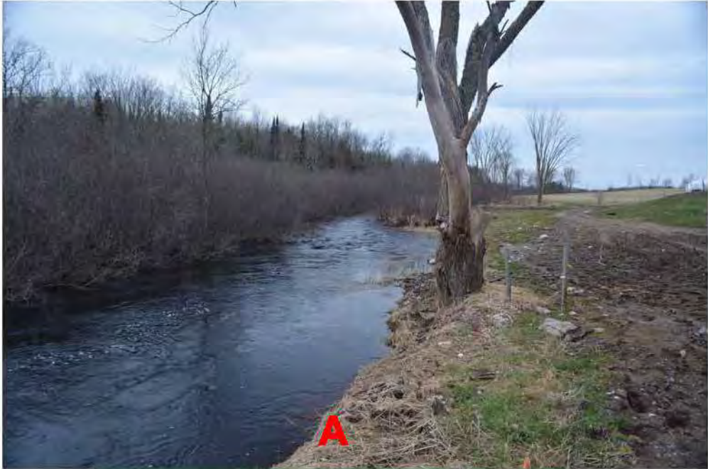
Foytik FP-10 Runway: Direct conduit
